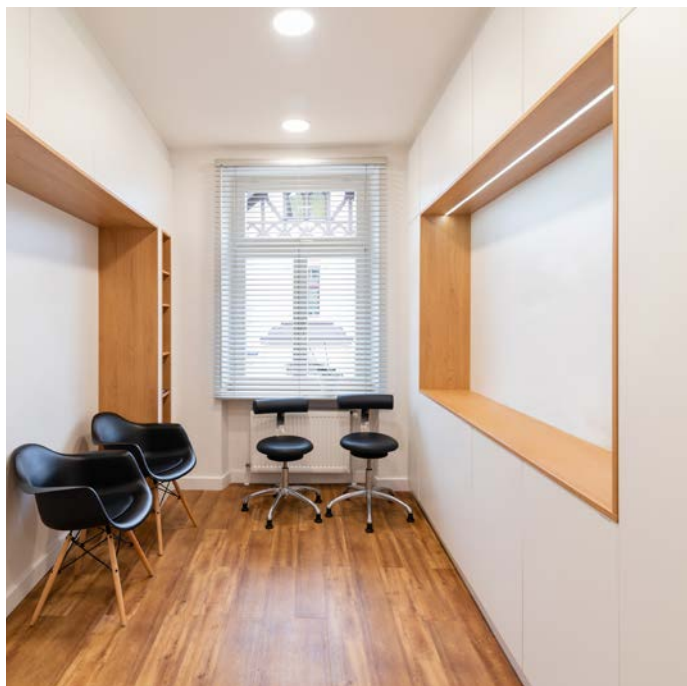
Abb.: Runde, weiße Deckeneinbauleuchten sorgen für eine schattenarme Lichtverteilung und ein ausgeglichenes Beleuchtungsniveau. In die Möbel eingebaute LED-Linien ergänzen das Lichtkonzept.
